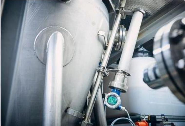
Medida de nivel en tubo bypass a través de microondas guiado.
