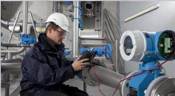
Medida de caudal en tubería mediante caudalímetro electromagnético.
