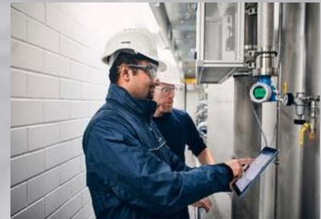
Medida de interfase en tubo bypass con microondas guiado.
